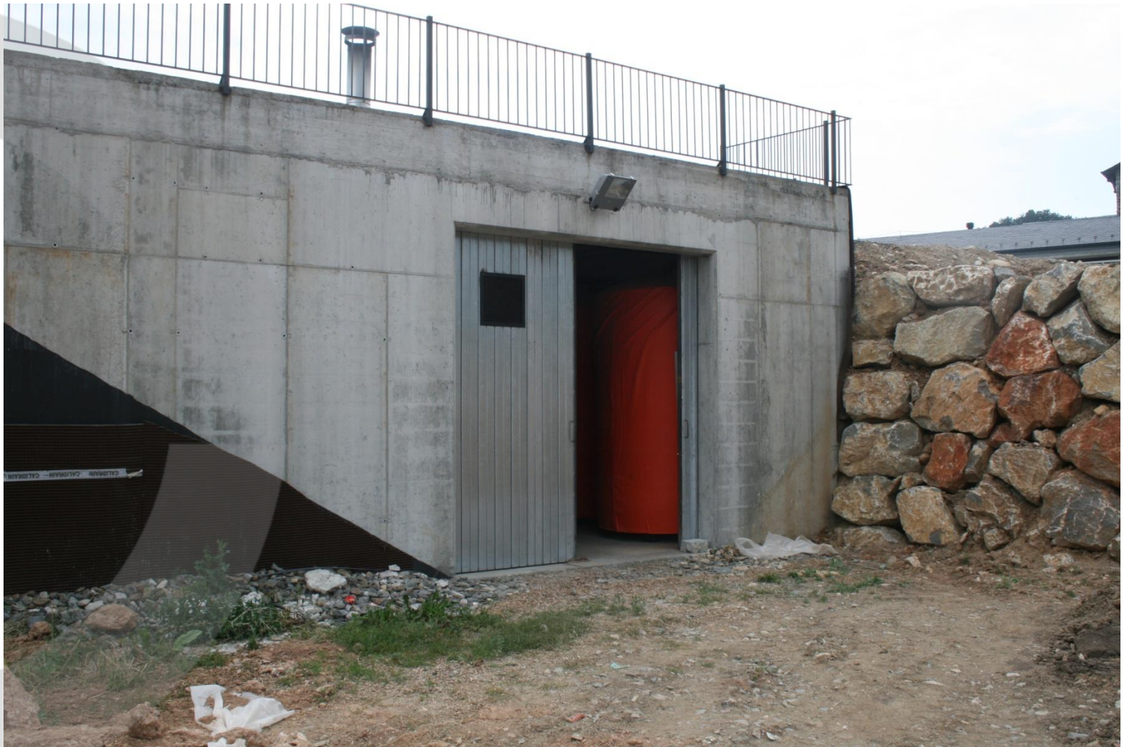
EXTERIOR SALA DE CALDERES
