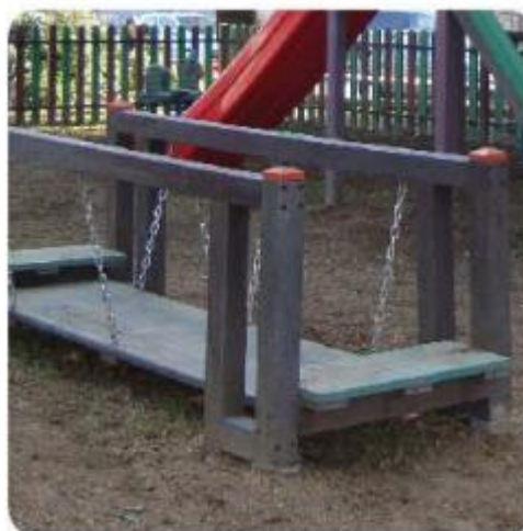
4. Col·locar a nivell 0 recolzant el peu més Curt de l'element tocant a terra.
