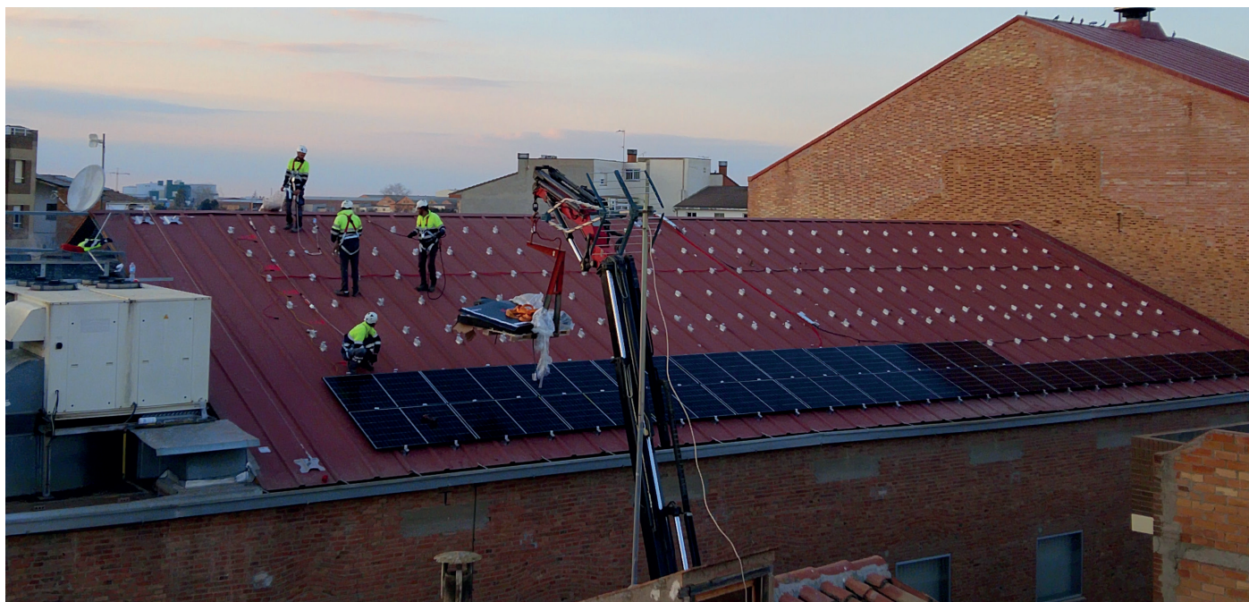
Tècnics instal·lant panells fotovoltaics a la teulada del Teatre Armengol de Bellpuig. Foto cedida per Ecobs.
