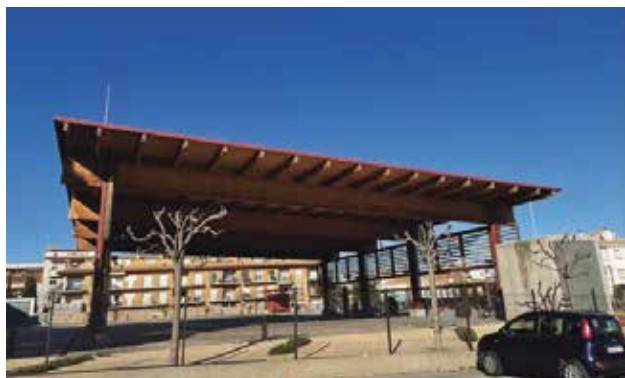
Coberta de la Plaça de Catalunya de l'Escala on s'instal·laran plaques solars. Foto: ACN.
