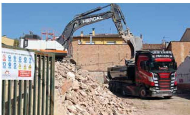
Operaris treballen en l'enderroc de l'antiga caserna de la Guardia Civil de Manlleu. Foto: ACN.
